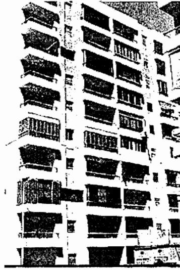
( شكل ٩، أ، ب) الآثار الناتجة عن ضم البلكونات إلى الحيز الداخلي بمختلف أنواعه على الواجهات
