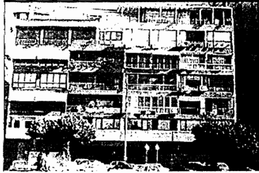
( شكل ٩، أ، ب) الآثار الناتجة عن ضم البلكونات إلى الحيز الداخلي بمختلف أنواعه على الواجهات
